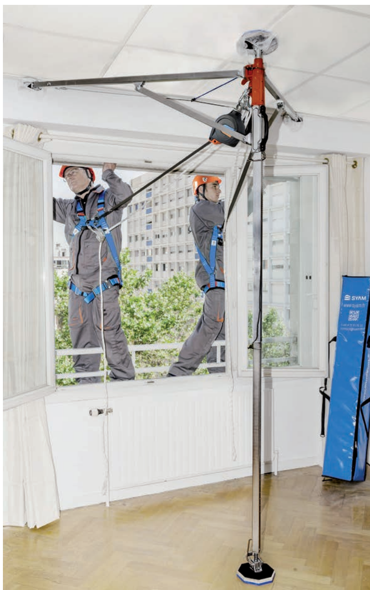
Deux menuisiers poseurs se sécurisent grâce au SYAM ©SYAM
